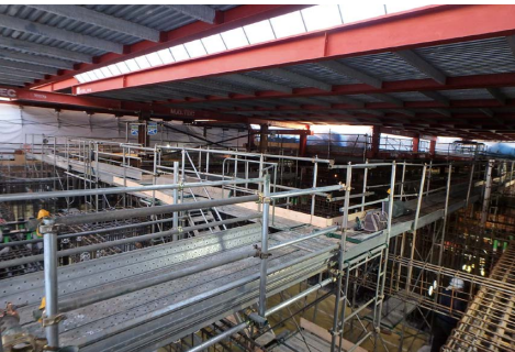
仮設養生上屋内
