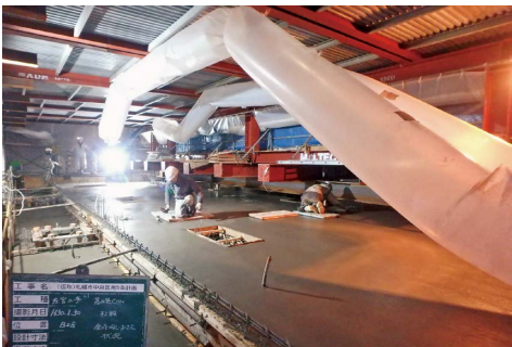
コンクリート打設状況(採暖養生ファーンセダクト設置)
